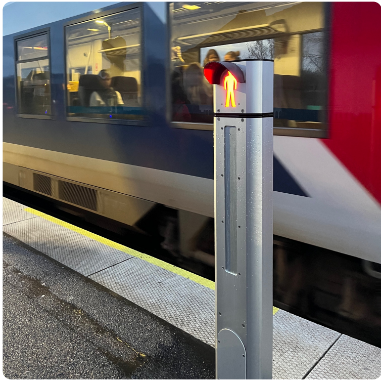
Varslingsanlægsstandere installeret ved Asnæs station.
